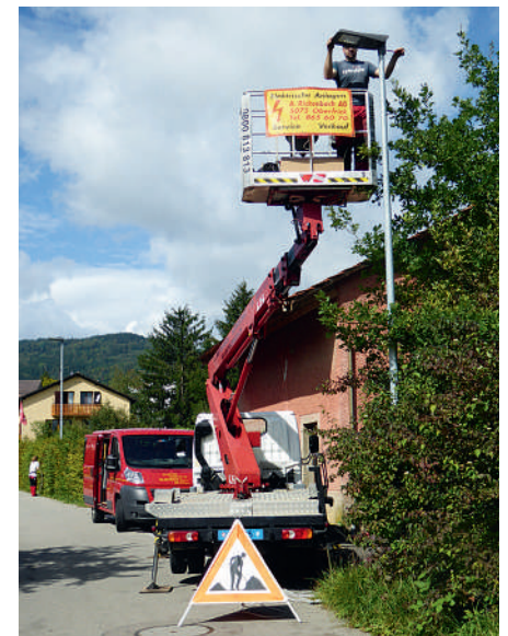
In luftiger Höhe wird die Strassenbeleuchtung von der Firma Rickenbach AG auf sparsame und effektive LED-Beleuchtung umgerüstet.
