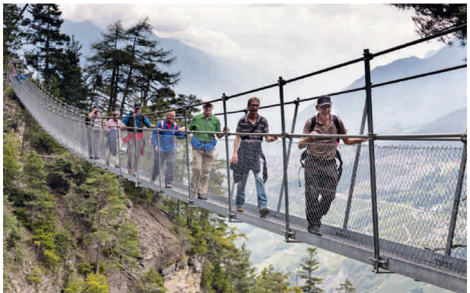
In luftiger Höhe dem Weg der Saone (dem Bewässerungssystem) entlang. Etwas Mut war schon gefragt!
