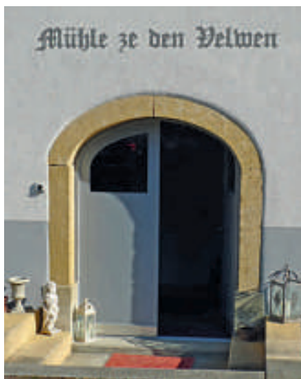
Renovierter Eingang der ehemaligen Mühle am Mülimattweg.
