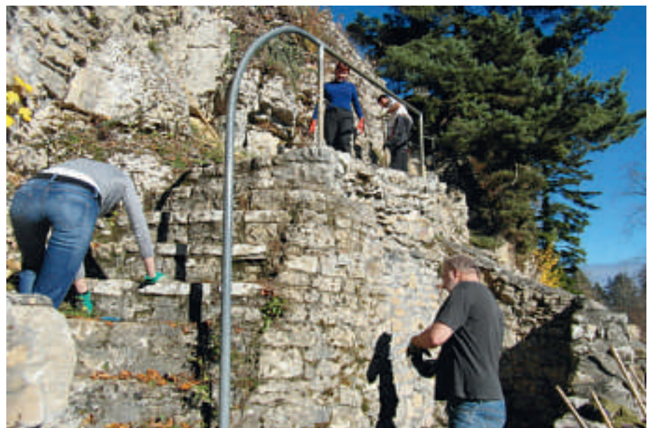
Treppen, Wege und Mauern wurden von Unkraut und Moos gereinigt.
