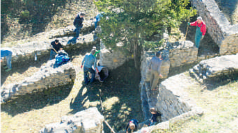
In allen Räumen der Ruine wurde fleissig gearbeitet.
