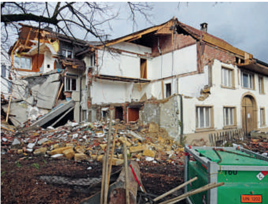
Nach einer längeren Planungs- und Baubewilligungsphase sind nun die Bagger im Unterdorf vorgefahren. Die ehemaligen Liegenschaften Wüthrich und Schmid weichen einer Überbauung der JKB Immobilien AG. Das Architekturbüro Bäumlin + John AG realisiert auf diesem Areal diverse 2,5 bis 5,5 Zimmer Eigentumswohnungen. Diese sind ab Sommer 2017 bezugsbereit.
