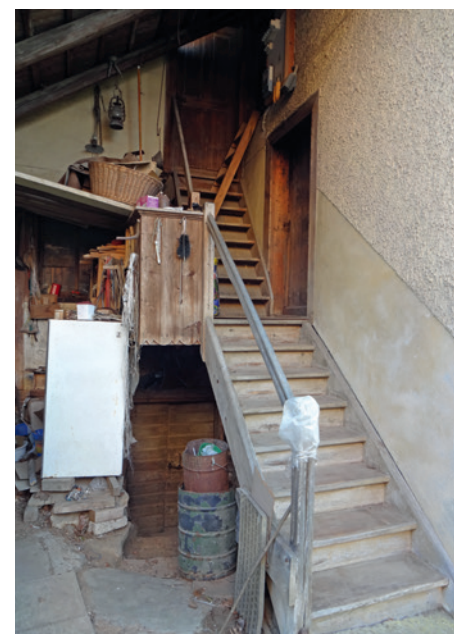
Aufgang zur Haustür.
