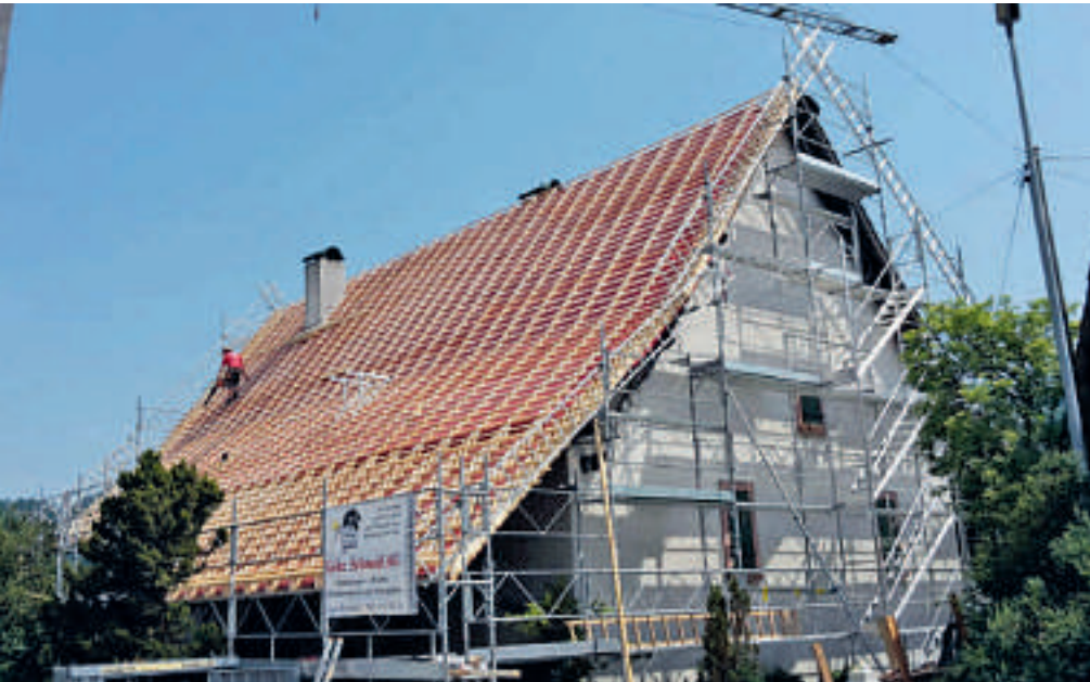
Ein Beispiel der täglichen Arbeit: komplette Dachsanierung und Neueindeckung einer Liegenschaft in Oberhof. Auch gut sichtbar der eigene Gerüstebau mit Dachsicherung.
