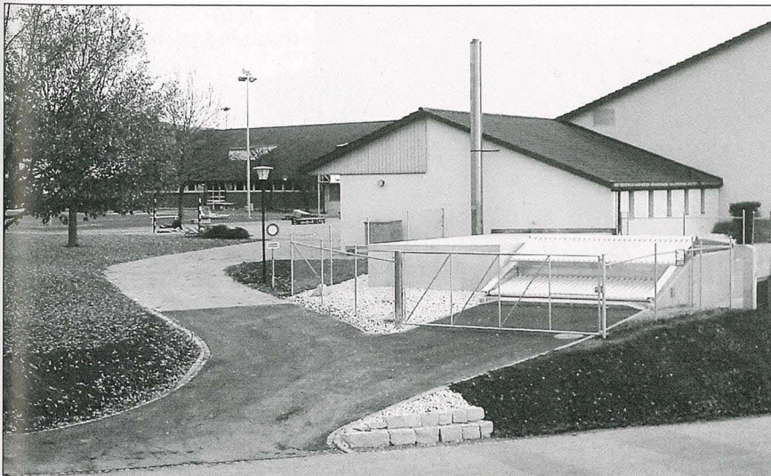
Gesamtübersicht Heizzentrale mit Anfahrt und Modulsilo
