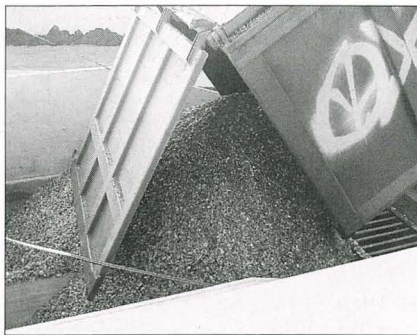
Das erste Befüllen durch die grosse Einfüllöffnung
