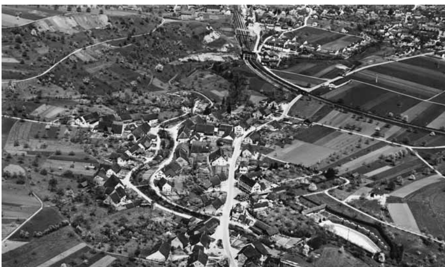
Flugaufnahme vom 1. Mai 1950 mit dem Ortsteil Gipf (Schwimmbad im Vordergrund)
