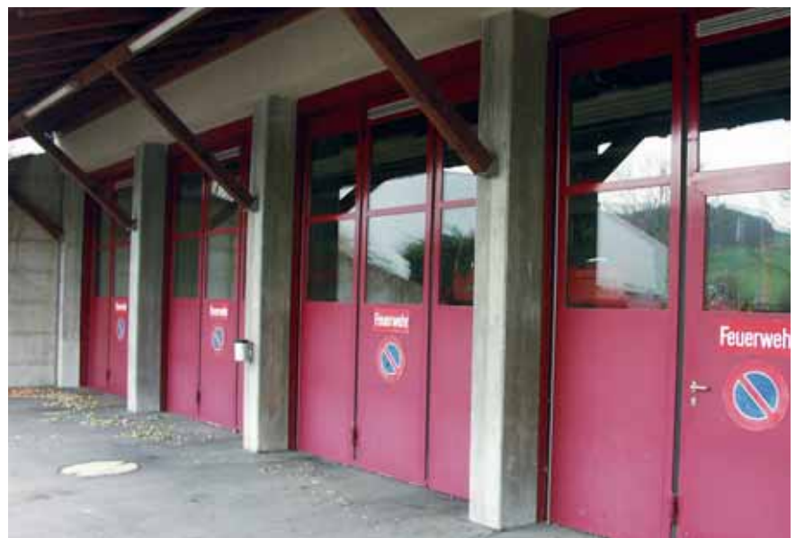
Fusion geplatzt: Die Feuerwehr bleibt im Dorf. Ob aber dieses Feuerwehrmagazin auch für die Zukunft genügt, wird sich zeigen.
