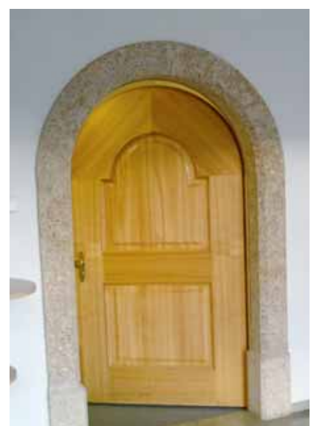
Türgewänd im Schalterbereich der Bank 1979–2008 mit Türe aus Oberfricker-Kirschaumholz
