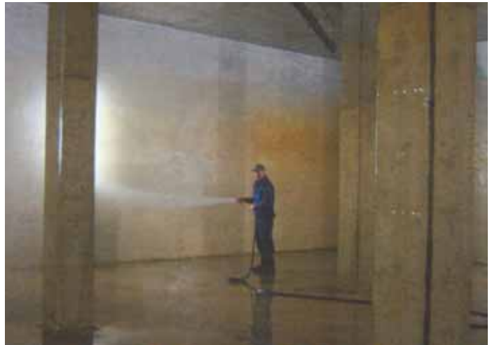
leerer Reservoir-Teil Langwied bei der Reinigung. 500 m 3 Inhalt.
