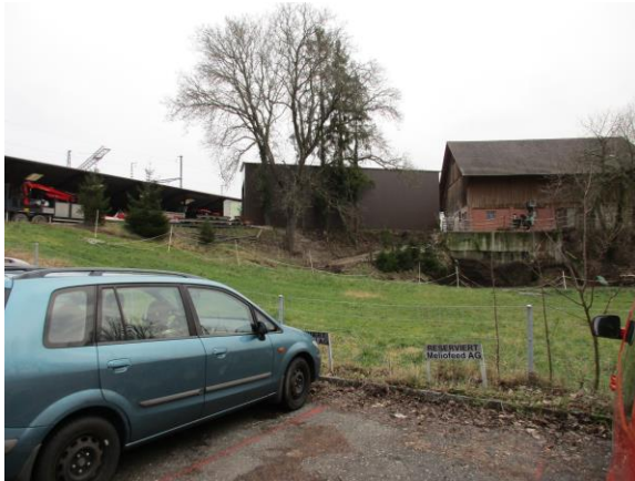
Foto: Parkplatz Richtung Gebäude Nr. 243.
