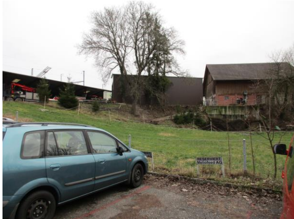
Foto: Parkplatz Richtung Gebäude Nr. 243.
